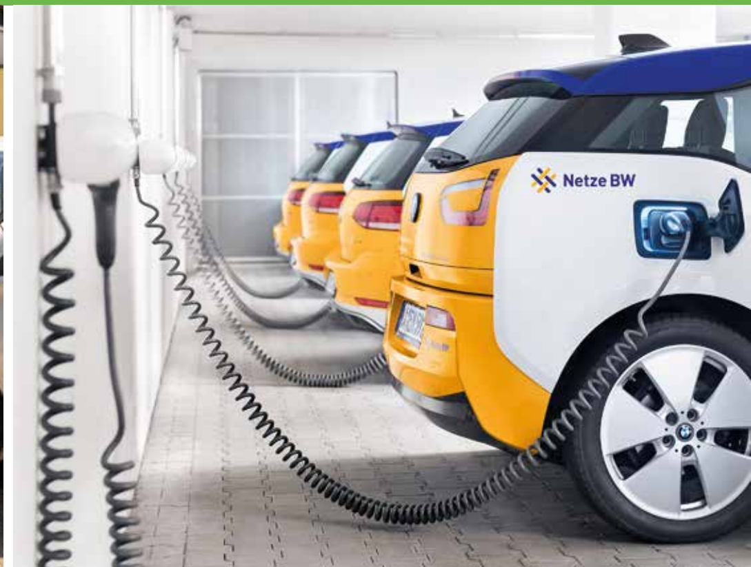
Im Projekt E-Mobility-Carré wird das Laden in einem städtischen Mehrfamilienhaus in Tamm bei Ludwigsburg untersucht. (Quelle: Netze BW)
